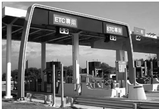
図 2 高速道路設備
